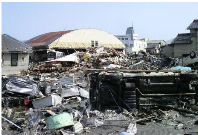
【全壊した宮城交通気仙沼営業所】
