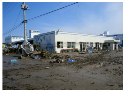
【津波で土砂に埋もれた事務所】
