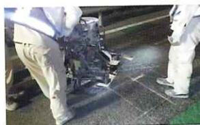
逆走対策工事 作業状況
